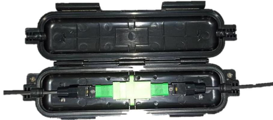
Realizamos el conector, colocamos el modulo y cerramos herméticamente la manga.
